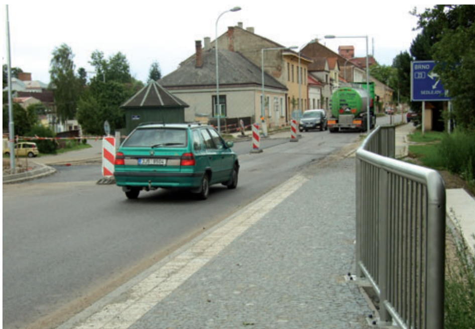
Bliží se dokončení jednoho z kritických míst náročné stavby. Most přes Telčský potok ve Štěpnici je zcela nový.
